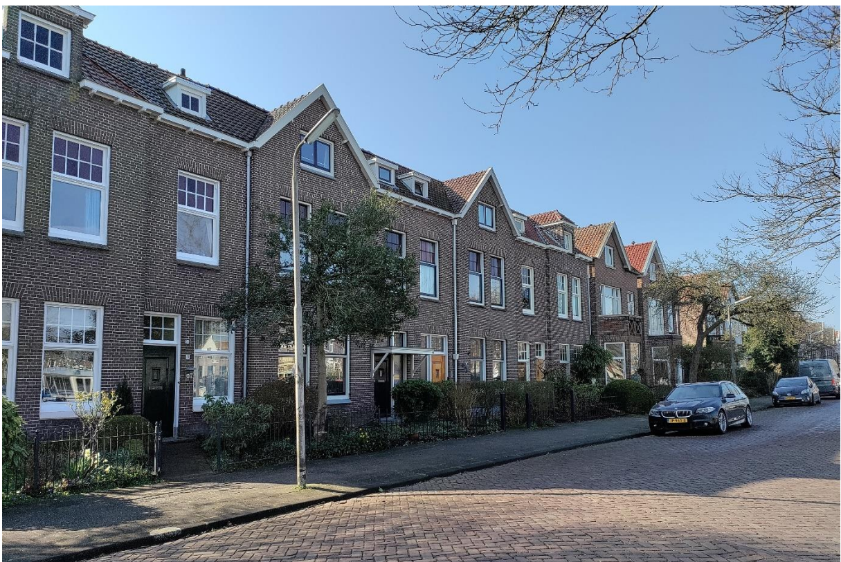
Variatie in daklijnen, gevels, erkers en rooilijnen binnen een strak architectonisch kader
