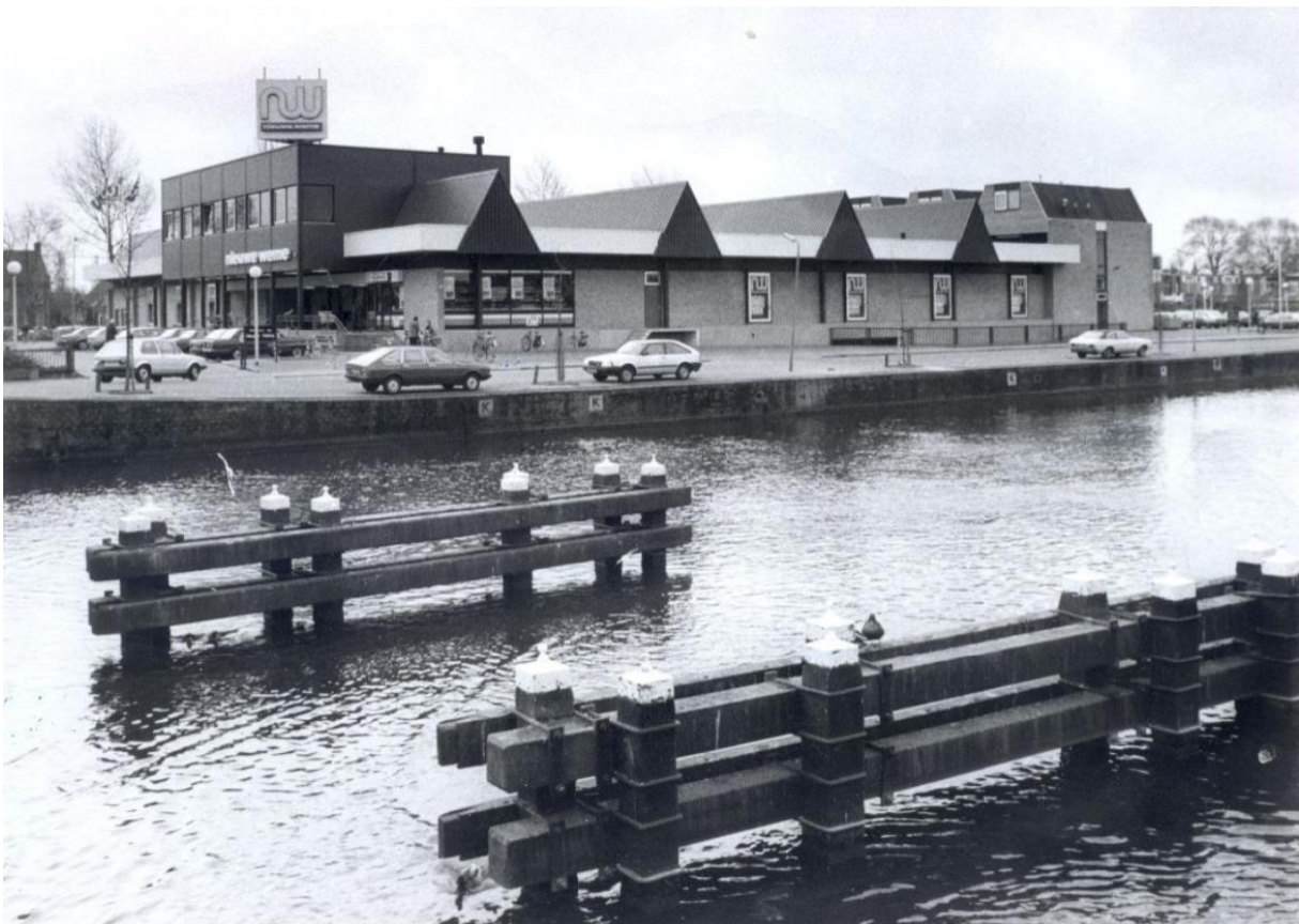
Nieuwe Weme met kantoor en woningen op winkelblok met entree kelder vanaf de Emmakade, 1984
