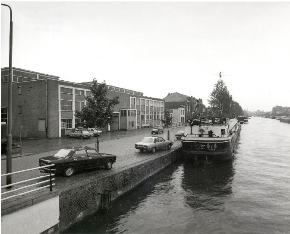
Condensfabriek, 1981 (Dikken & Hulsinga)
